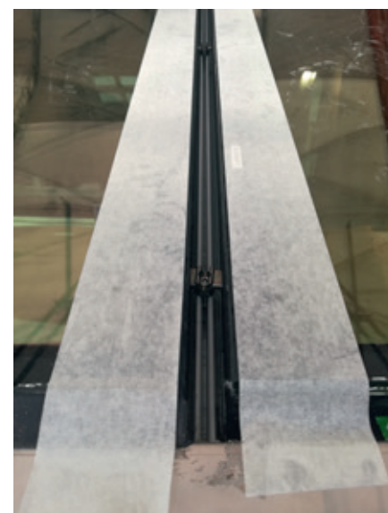
Ruderne er lagt op og klar til at blive fuget.
