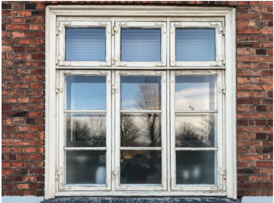
De originale vinduer fra 1917 ønskedes bevaret og opdateret med indvendige forsatsløsninger.
