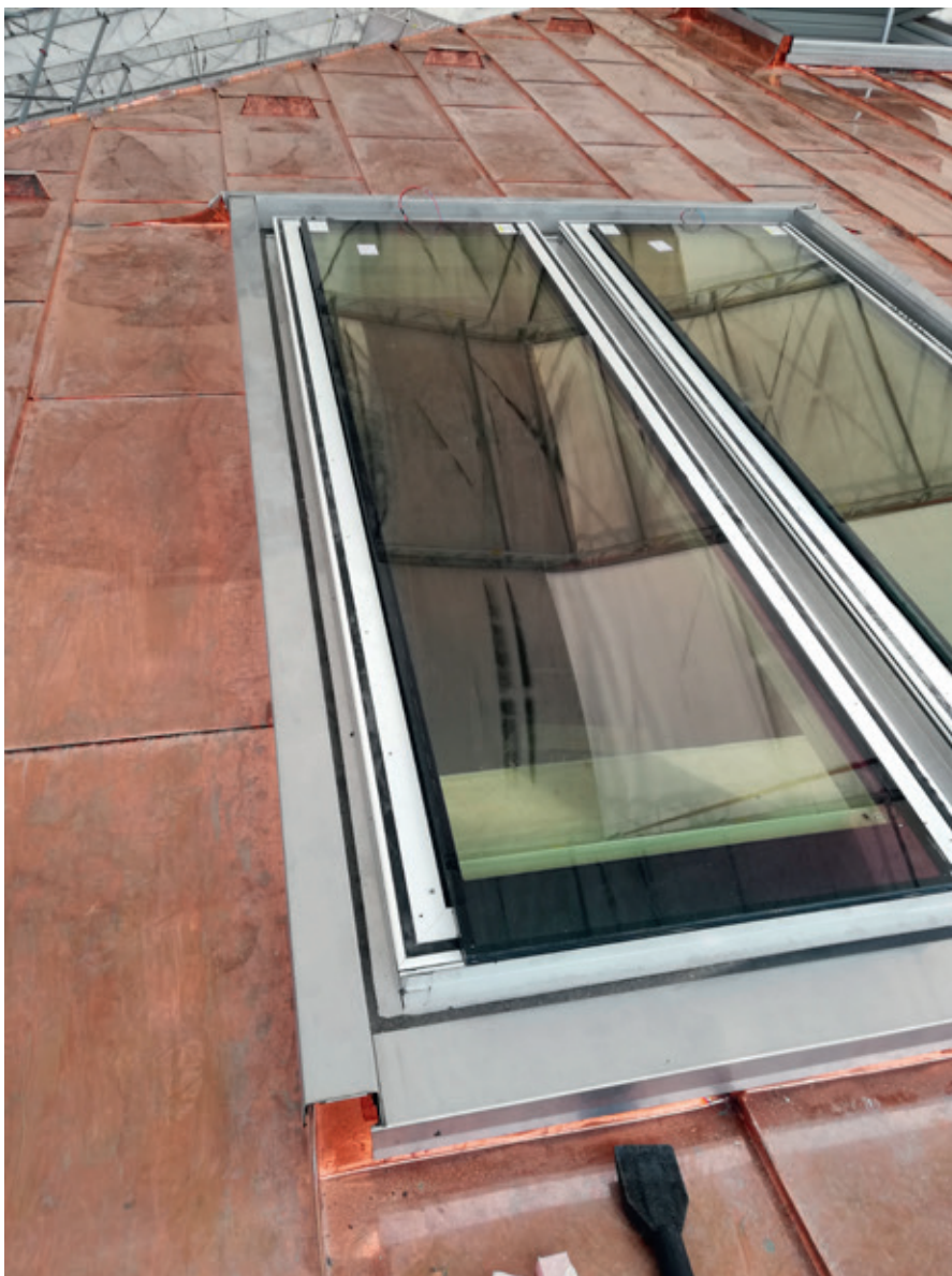
Et af de oplukkelige vinduer, hvor ruderne netop er blevet lagt op.
