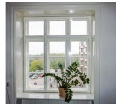
Forsatsløsningerne er en diskret og elegant måde at isolere og støjdempe de originale vinduer.
