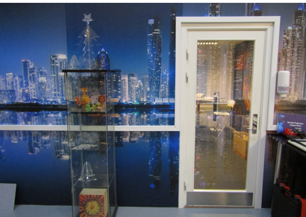
Hul film. På billederne ses hvordan one way vision filmen kun fungerer, når der er mørk i det rum, der ikke ønskes indkig til. Udførelse: Singcom, Foto: Mikkel Thomsen
