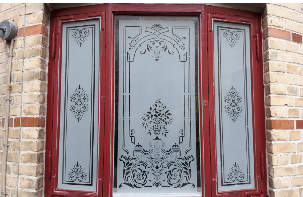
Sandblæste ruder. Renovering af oprindeligt dørparti på Amager. Arbejdet er udført i samarbejde med Glarmester Frese og søn. Foto: Ballusign Decor-glas.
