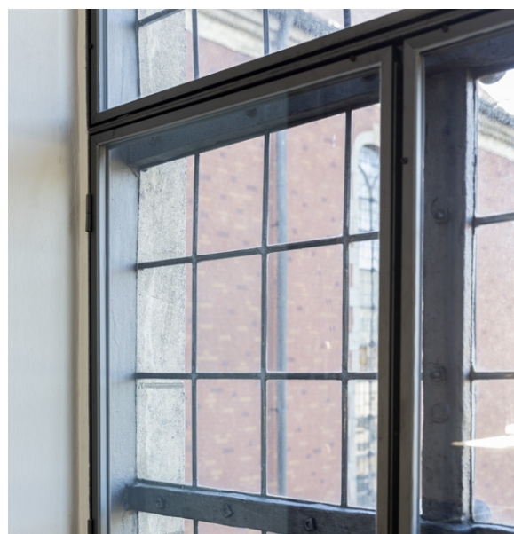
Indvendigt bag blyruderne blev der indmuret vinkelstål, hvorpå forsatsruderne udført af grafitmalet aluramme blev monteret.
