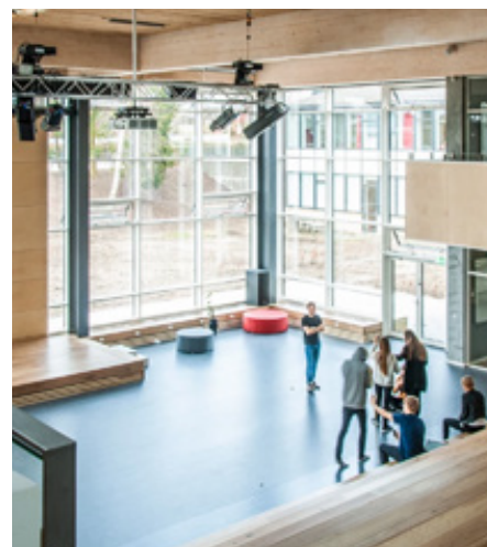
Moderne glasfacade på Birkerød Gymnasium: Vinduer med naturlig ventilation, styret af moderne teknologi (WindowMaster). Arkitekten er Tegnestuen Møllen.
