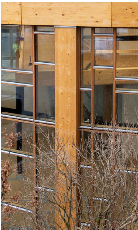
Parterrets facadepartier af glas er udført som 'puslespil' med de til rådighed værende energiruder i færdige mål som spillets brikker.
