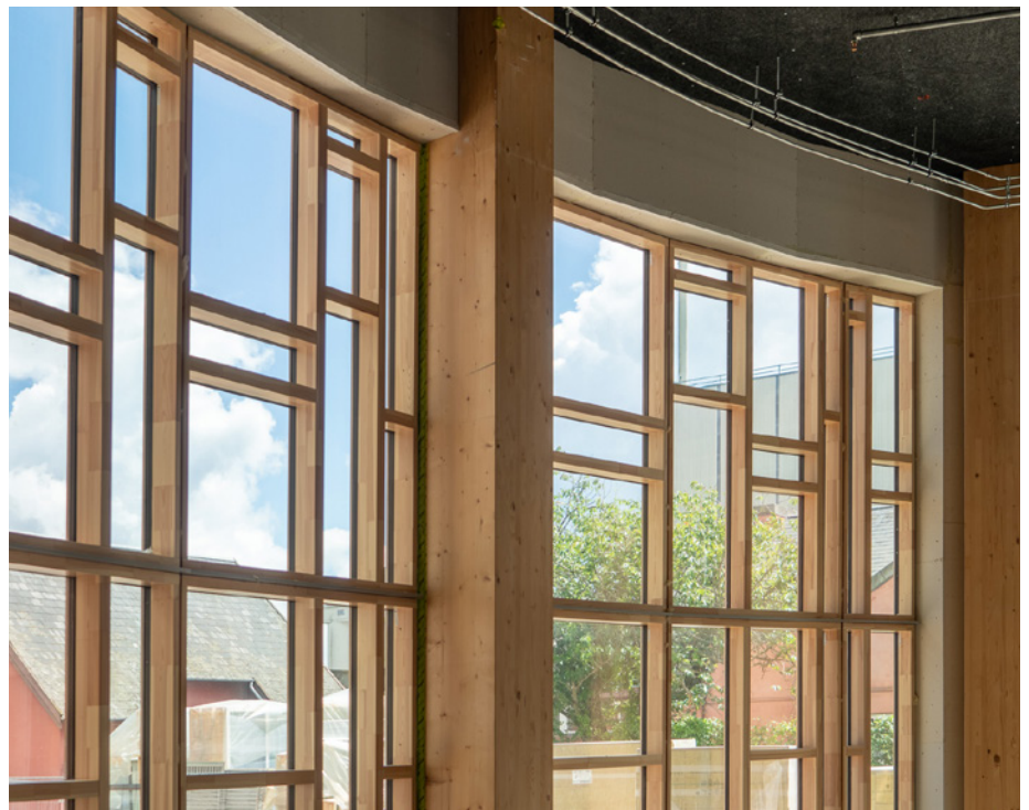
Leverandøren af glaspartierne opfordrer til at maksimere vindueshullerne for at øge den flade, hvorpå 'puslespillet' kan samles.
