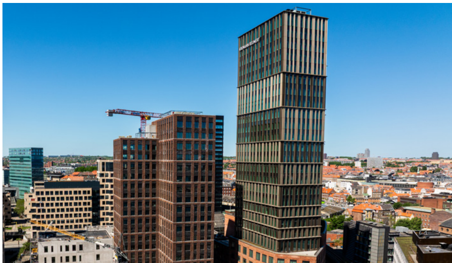
Facaderådgiver, civilingeniør Martin Lading, CW|A Advisors, er netop nu tilknyttet højhuset Akson Business Tower på Aarhus havn. Her arbejdes med slanke rudeformater i et transparent 'grid'. Arkitekten er AART A/S.
