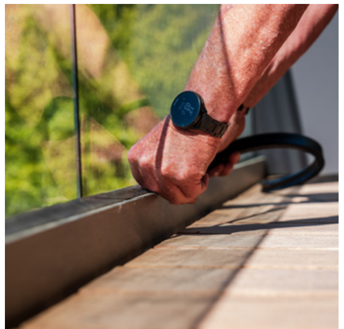
Glassene i bundskinnen kan monteres fra den indvendige side.
