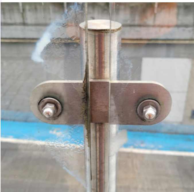
Meget lille møtrik, som er spændt hårdt mod glasset, medfører stor risiko for delaminering og misfarvning.
