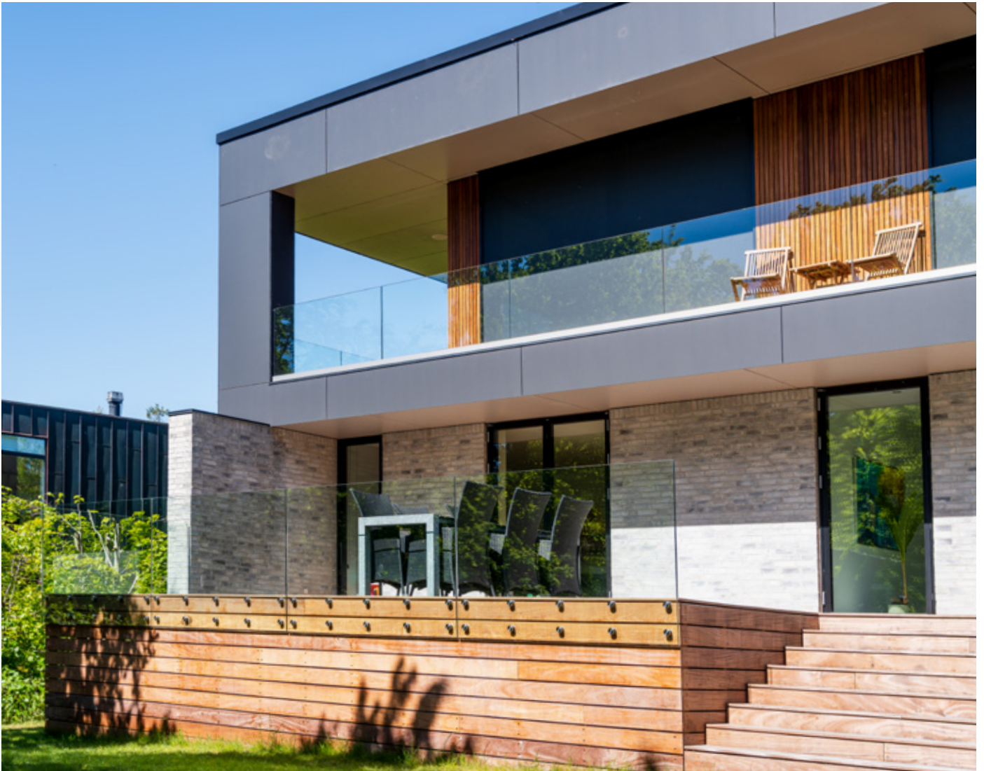
På den øverste terrasse er anvendt glasværn monteret i bundskinne, og på den nederste terrasse er glassene monteret med gennemgående bolte.
