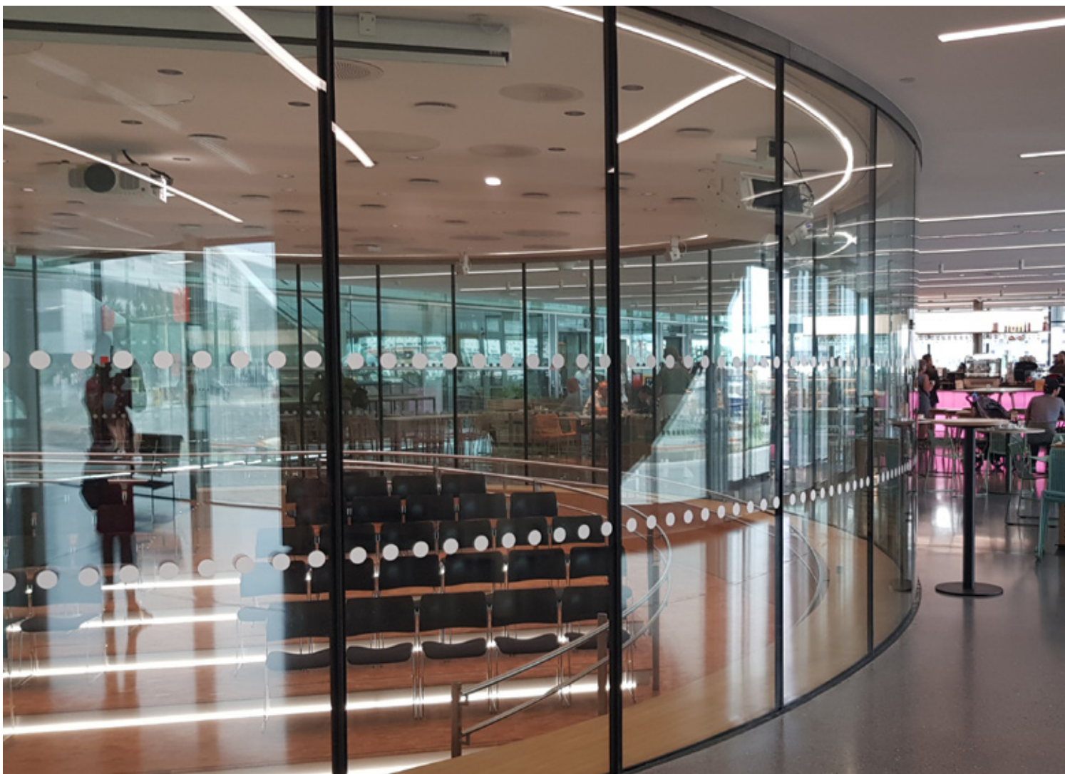
Prikkene kan nemt forsvinde på en forvirrende baggrund af spejling og kunstlys. I dette tilfælde, kan der trækkes et gardin for auditoriet langs glasfacaden, og da bliver baggrunden roligere og prikkerne tydeligere. Det ser man til højre i billedet ved en anden glasvæg.
